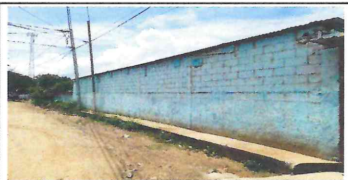
Foto 5: Reparación de muro perimetral
