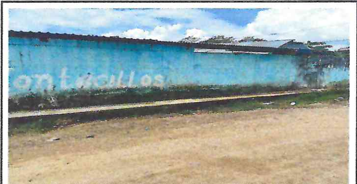
Foto 4: Reparación de muro perimetral
