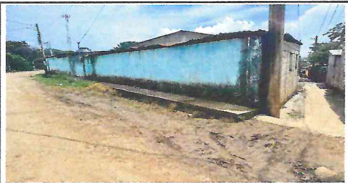
Foto 3: Reparación de muro perimetral
