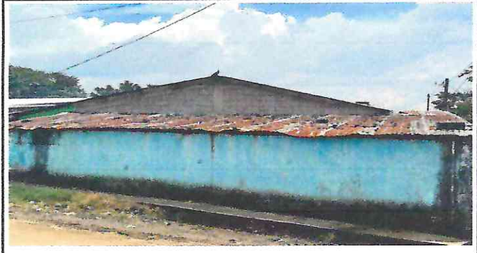
Foto 2: Sustrucción de lamina acanalada por lamina troquelada
