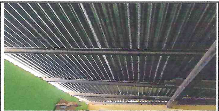
Foto 6: Sustrucción de estructura metal por metal
