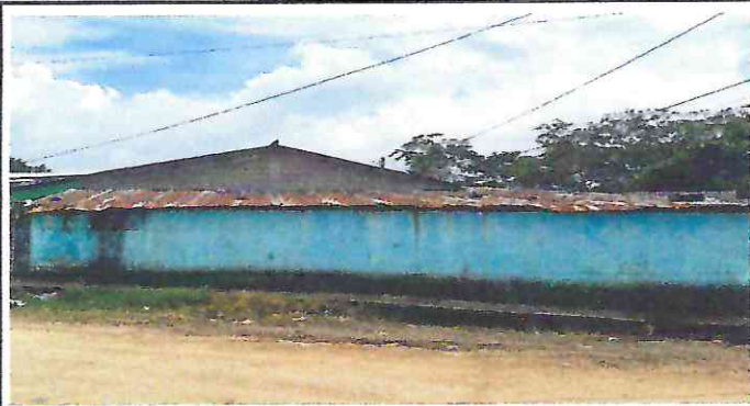
Foto 1: Sustrucción de lamina acanalada por lamina troquelada
